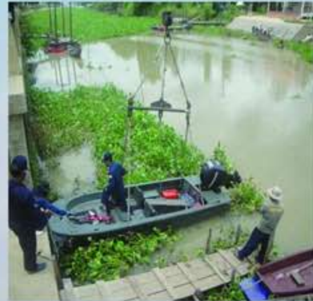
การยกเรือจุกโจมลำน้ำจากรถบรรทุกลงน้ำ
